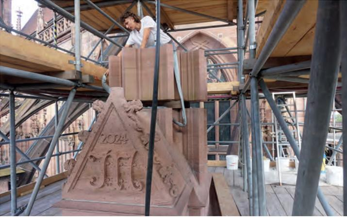
Aufbau einzelner Neuteile am Strebepfeileraufsatz 13/14 Süd
