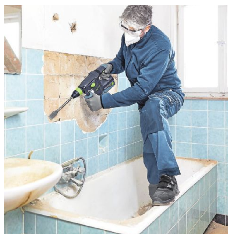
Das pneumatische Schlagwerk des Kombihammers KHC 18 entwickelt eine Kraft von 2,6 Joule. Schwingungen werden gedämpft. Foto: Festool
