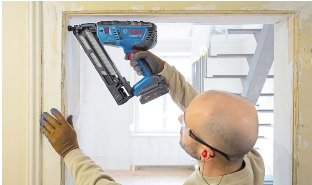
Der stärkste unter den neuen Akku-Naglern eignet sich unter anderem zum Anbringen von Fenster- und Türzargen bei einer ähnlichen Leistung wie ein Druckluftgerät. Foto: Bosch
